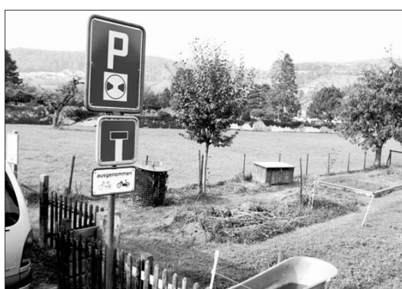
Hier entstehen die neuen Parkplätze.
